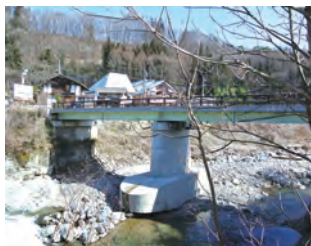
被災した三松橋
