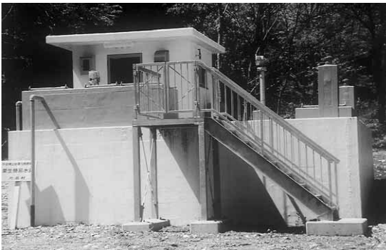
新しくなった栗生配水池全景
