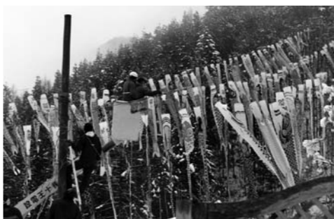
設置作業の様子
