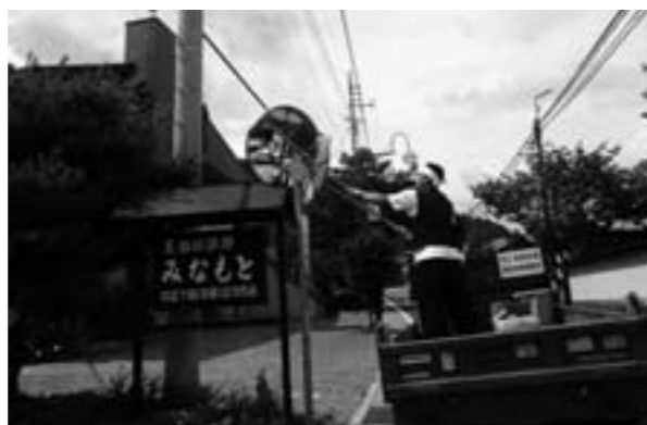
安全運転のためカーブミラーを清掃
