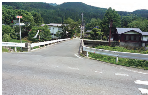
改修工事を行うことになった学校橋
