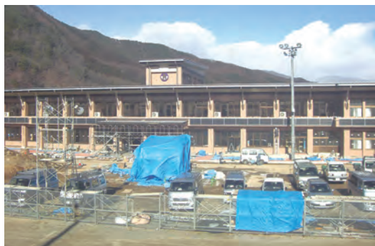
完成間近の片品小学校新校舎
