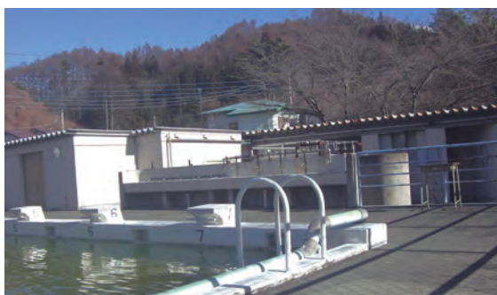
プールが解体され跡地に臨時校舎が設けられる
