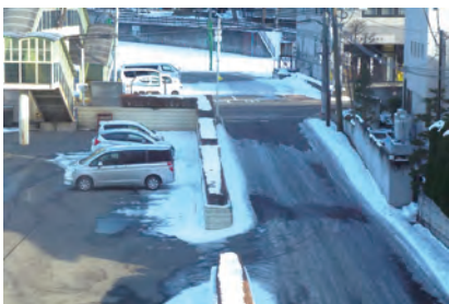
拡幅を予定している役場横の村道
