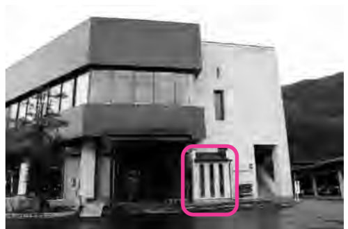
東側入口横に新設された喫煙室
