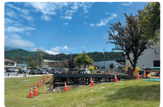
建設中のテラス
